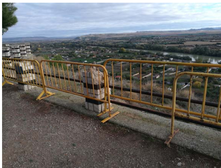
Estado actual de la protección del mirador.
